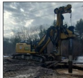
Equipo de perforación
